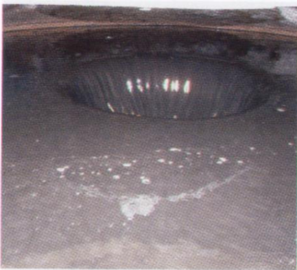
Rückspülung bei 20 Prozent Filterbettausdehnung
