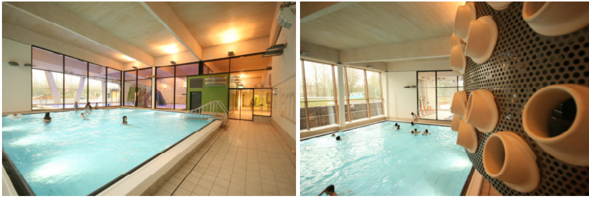
Abbildung 7: Innenansichten von Halle 3 mit dem Lehrschwimmbecken mit Hubboden (links von Süden, rechts von Nord-Osten mit Zuluftelement)
