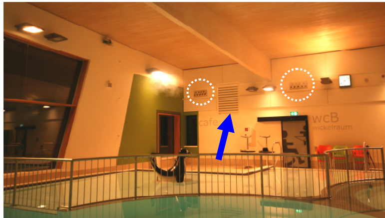
Abbildung 64: Nebelversuche in Halle 1+2 in der Nacht vom 05. auf den 06.12.2012. Blick auf die Außenwand (links) und die Wand zu den Umkleidebereichen (rechts). Im Bild sind zwei Zuluftdüsen (Kreise) und das Abluftgitter (Pfeil) gekennzeichnet.
