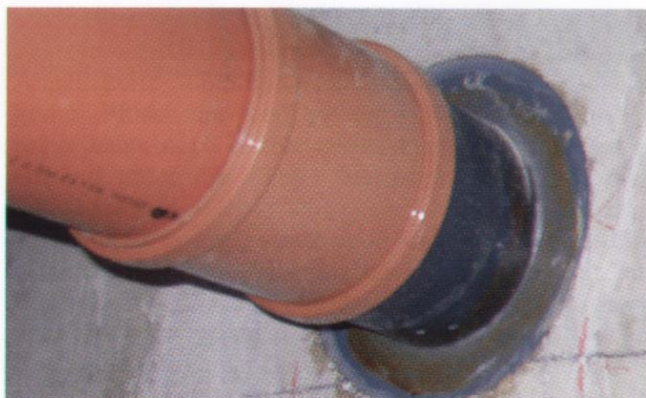
Neuer Rinnenablauf im Beckenumgang
