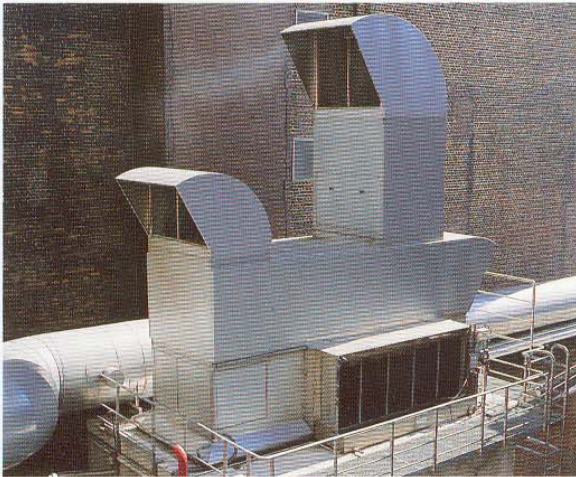
Die im Freien auf einem Dach installierte Gasturbinenanlage.
